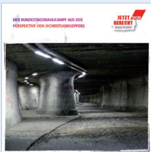
Matenatunnel in Duisburg
